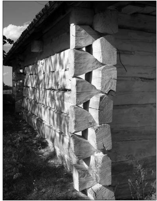
Кутова врубка з випусками торців типу риб'ячий хвіст; с. Карасин
