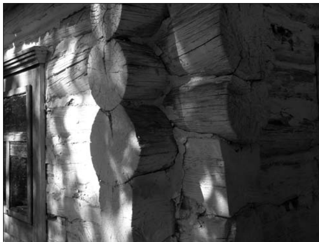
Зруб із колод з верхньою драчкою; с. Кураш Володимирецького р-ну Рівненської обл.
