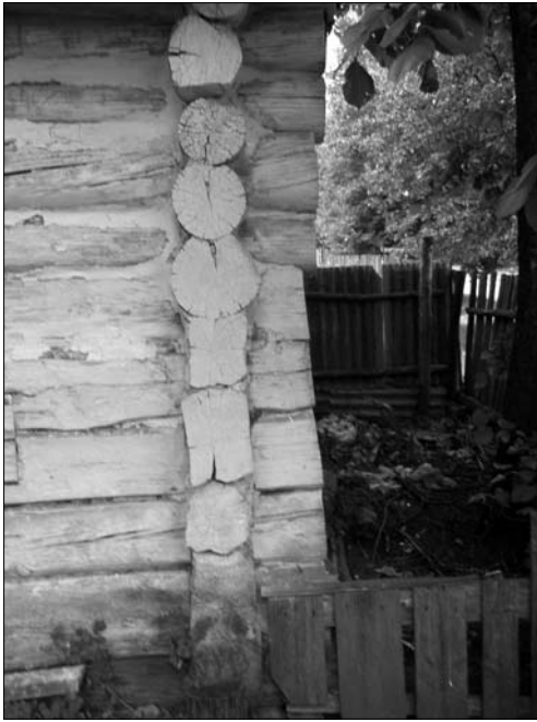
Поєднання у зрубі вінців із верхньою та нижньою драчками; с. Кураш Володимирецького р-ну Рівненської обл.
